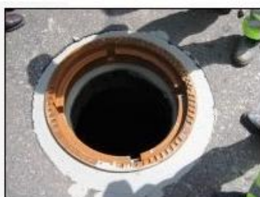
po 35 minutach usuwamy szalunek rurowy
