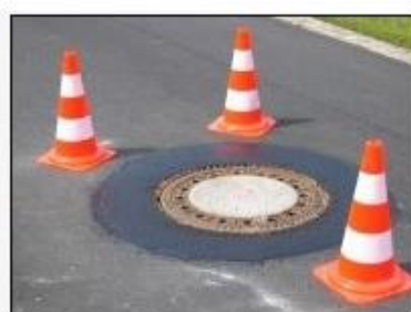
po 45 minutach wyrównujemy zaprawą do naprawy asfaltu
