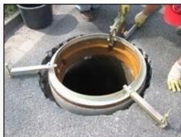
po 20 minutach zakładamy pierścień pokryw
