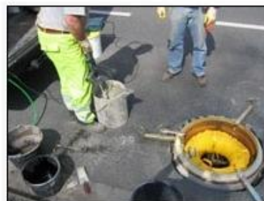
po 30 minutach zalewamy specjalną zaprawą
