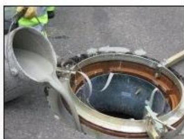
... zalewamy zewnętrzne pęknięcia
